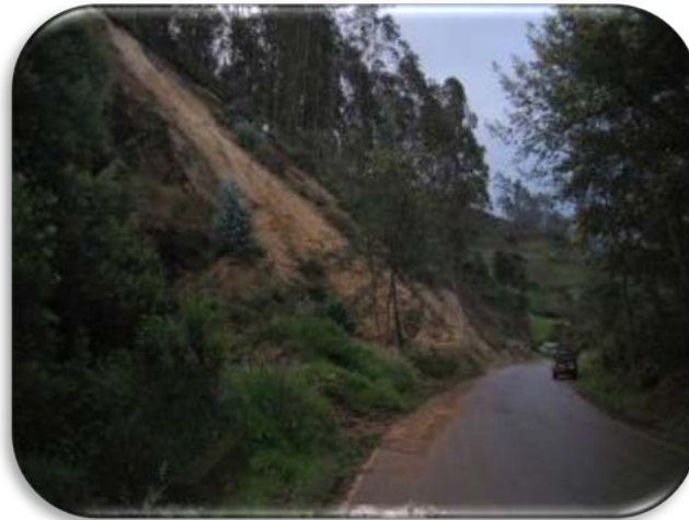
Foto 4. 9. Procesos de remoción en masa de la Formación Plaeners, este derrumbe amenaza con cubrir la vía en épocas lluviosas.
