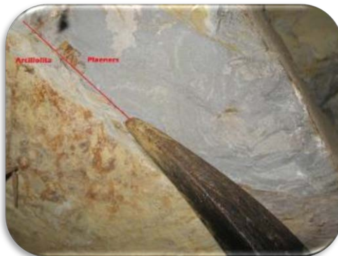
Foto 4. 8. Contacto entre capa de plaeners y láminas de arcillolita grises de la Formación Plaeners.
