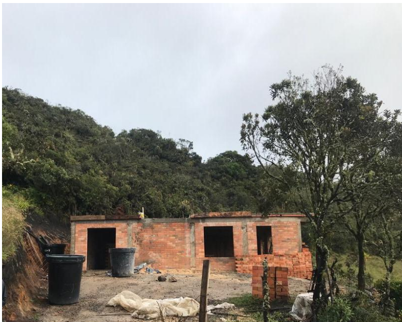
Figura 63 vivienda en construcción dentro del DRMI Cuchilla Mesa Alta
